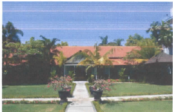
J. Bangunan sisi selatan gedung Balai Kota Madiun tampak utara
