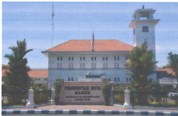
D. Foto gedung Balai Kota saat ini Madiun tampak barat
